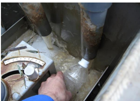
Nước xử lý cuối cùng
